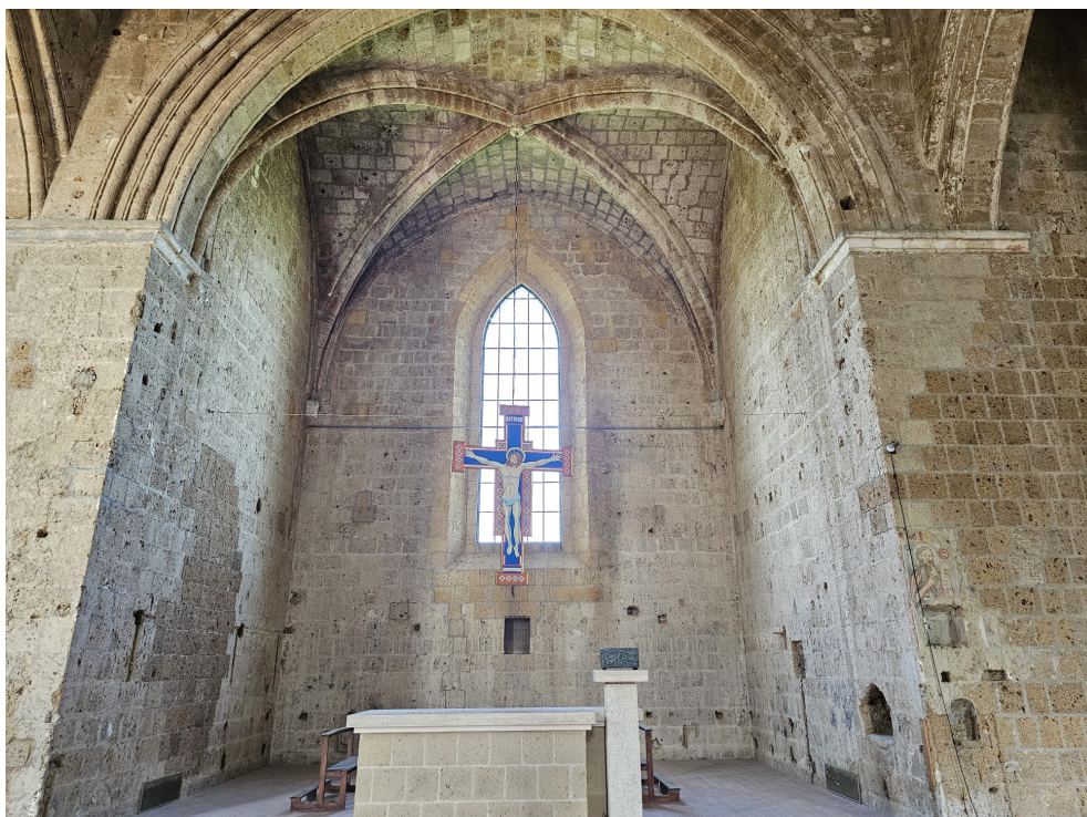
Figura 4. Interno della Chiesa
