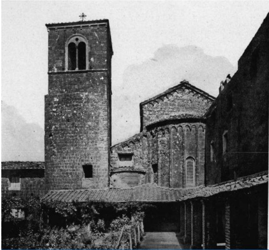
Vista esterna dell'abside XIX secolo
