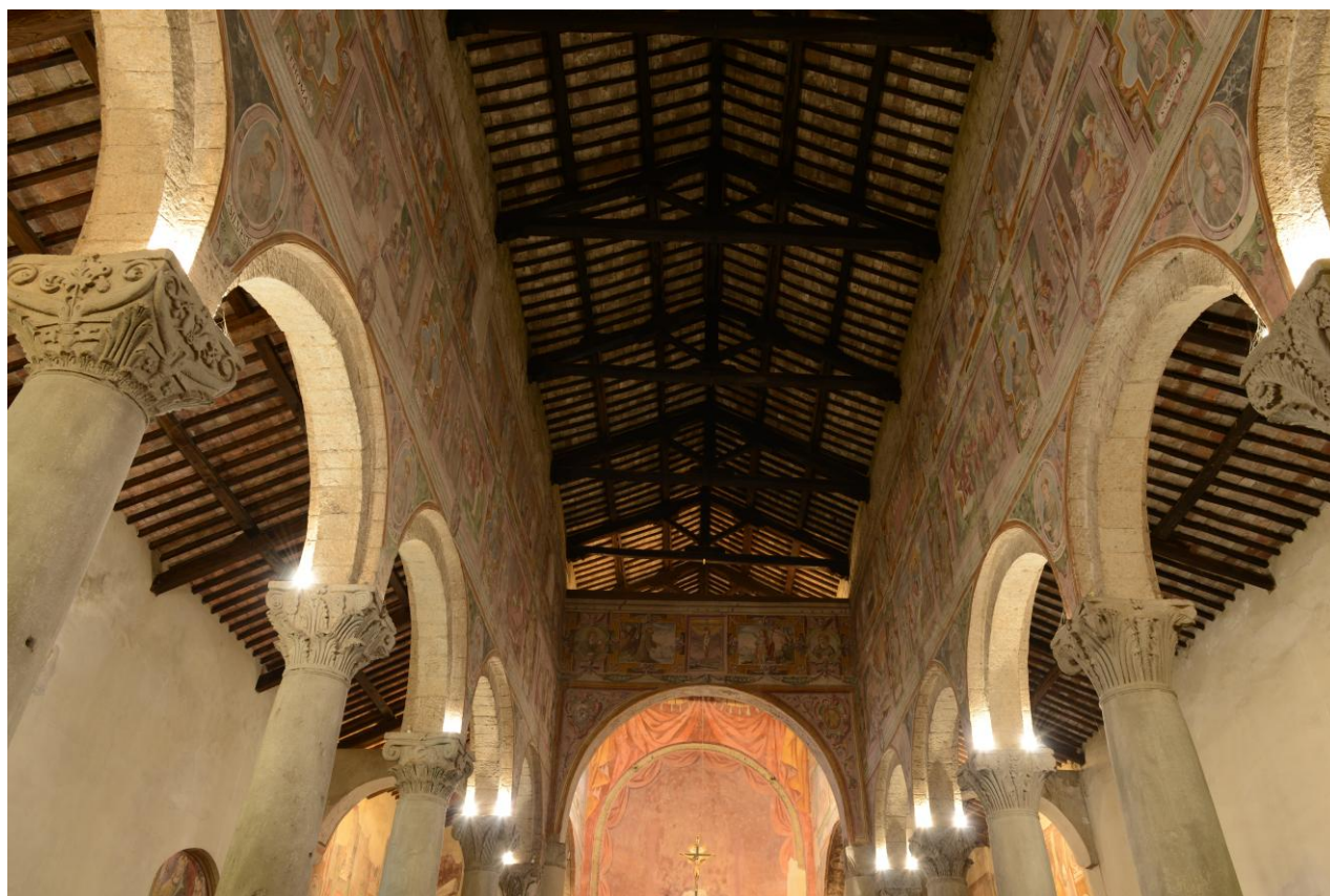
Vista della copertura a capriate della navata centrale
