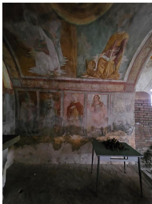
Si noti la linea evaporativa dell'umidità che ha già compromesso il 30% degli affreschi.
