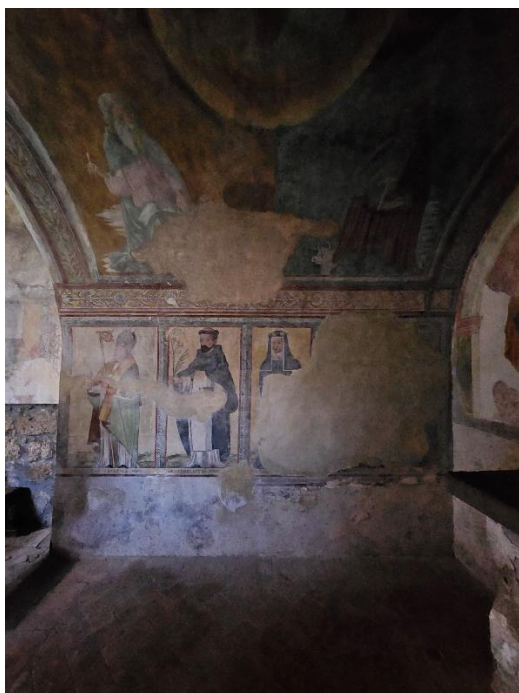
Si noti la linea evaporativa dell'umidità che ha già compromesso il 30% degli affreschi.
